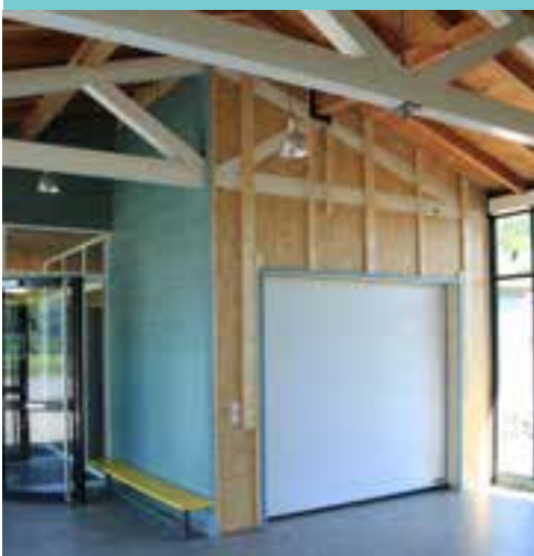
Das Stuhllager im Windfang wurde im Juni fertiggestellt.
